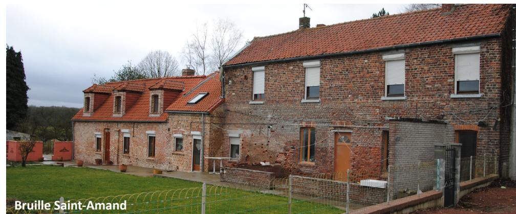
La prise en compte du sens de la pente permet de préserver l'identité paysagère du site et de ne pas perturber l'écoulement naturel des eaux de pluie. Il est donc préférable de **s'implanter** parallèlement aux courbes de niveaux et **ne pas remanier** le terrain, ce qui permet aussi d'éviter les coûts des déblais et/ou remblais.
