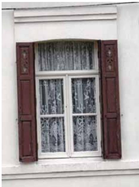
Volets en bois chantournés, à deux battants. Fenêtre à imposte. Cette baie a un linteau en arc surbaissé. Elle est haute et étroite selon le modèle traditionnel des ouvertures en Scarpe-Escaut.
