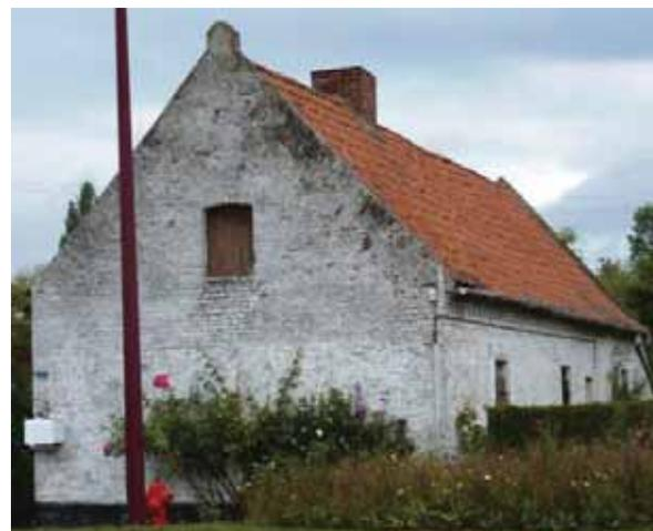
Maison élémentaire enduite à la chaux et soubassement goudronné pour protéger le pied du mur de l'humidité.
