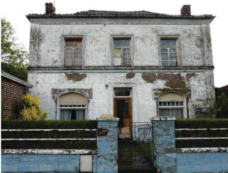
Maison bourgeoise enduite au ciment. L'enduit détérioré se détache des maçonneries par plaques et laisse entrevoir la maçonnerie de brique. Les encadrements de baies sont moulurés. Le Rivage.
