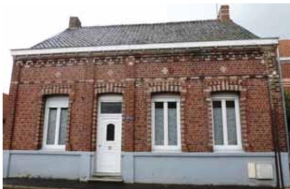
Maison élémentaire en brique rouge et briques de ciment avec soubassement de ciment peint apportant un effet de contraste avec la brique des maçonneries laissée à nu.
