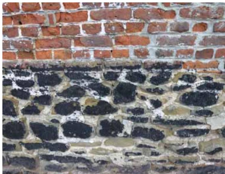
Mur de brique et soubassement en pierre dure peint traditionnellement avec une peinture étanche à base de bitume ou de goudron pour protéger le pied des murs des remontées capillaires.
