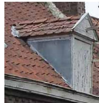
Lucarnes passantes (ou gerbière) à deux pans. Ce modèle est le plus répandu à Nivelle. On le retrouve surtout sur les toitures des logis de fermes.
