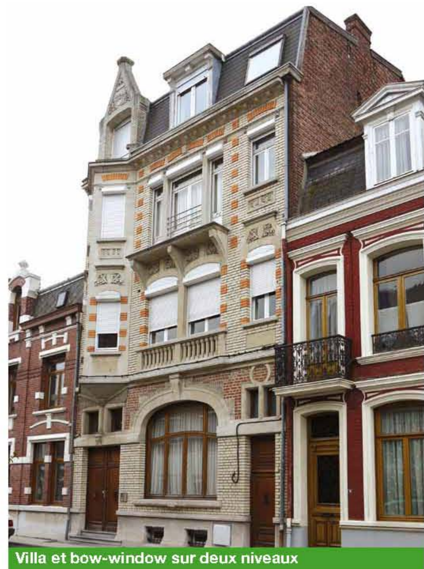
Villa et bow-window sur deux niveaux
