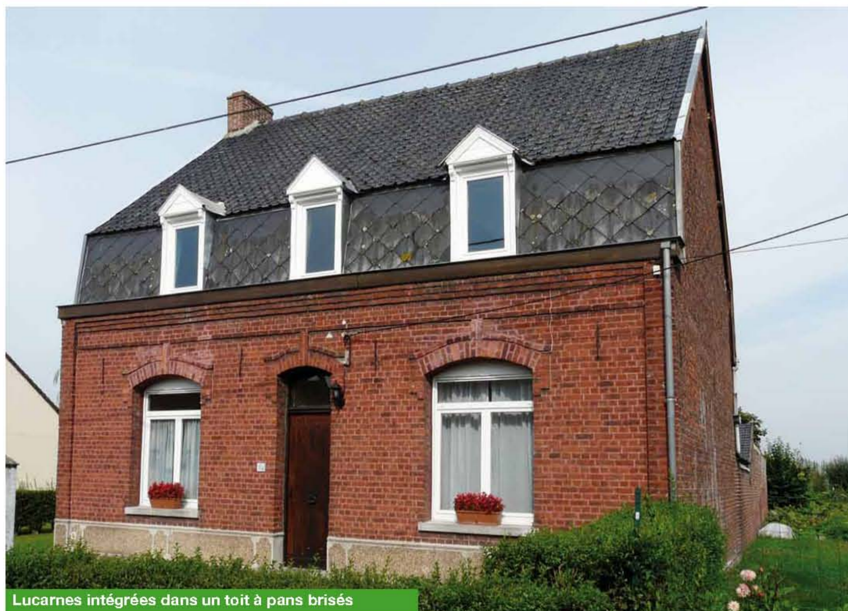
Lucarnes intégrées dans un toit à pans brisés
