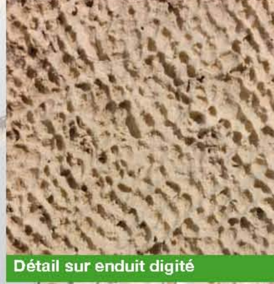
Détail sur enduit digité
