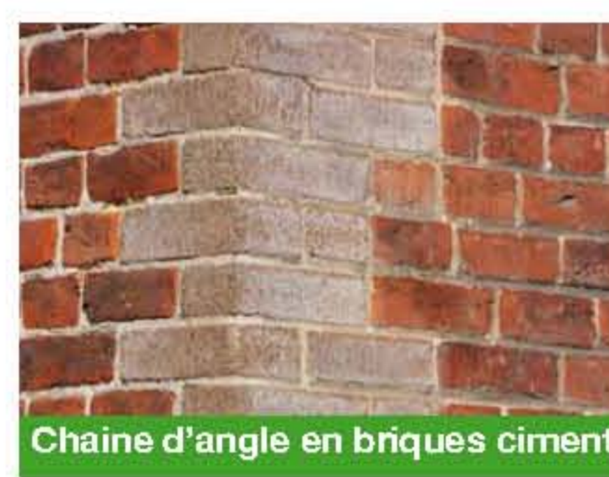
Chaîne d'angle en briques ciment
