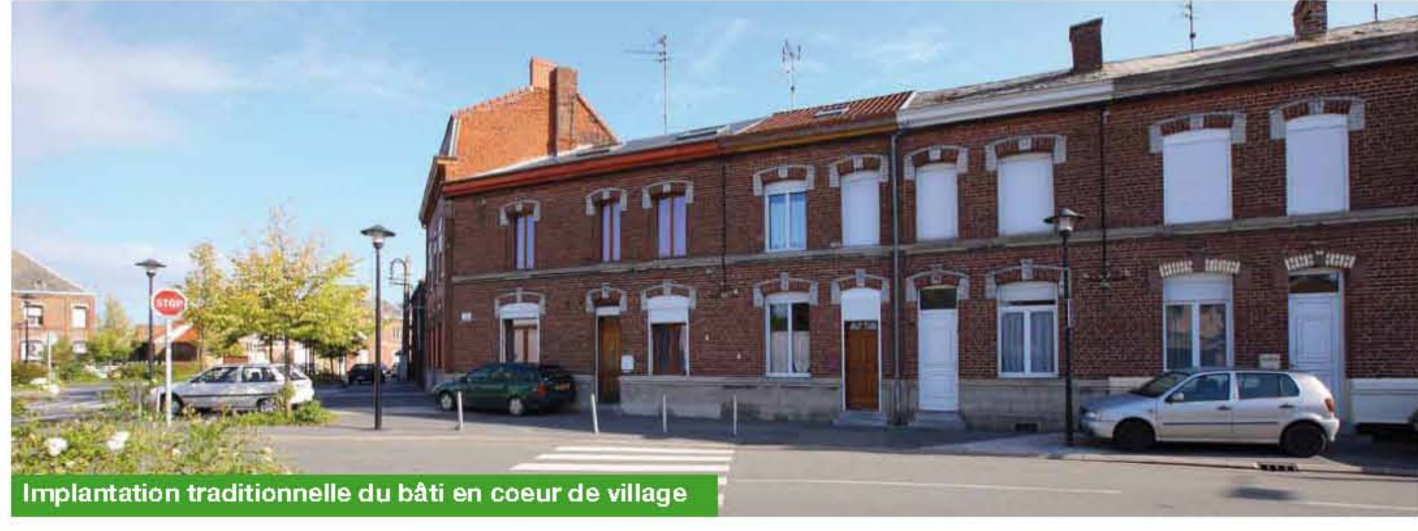
Implantation traditionnelle du bâti en coeur de village
