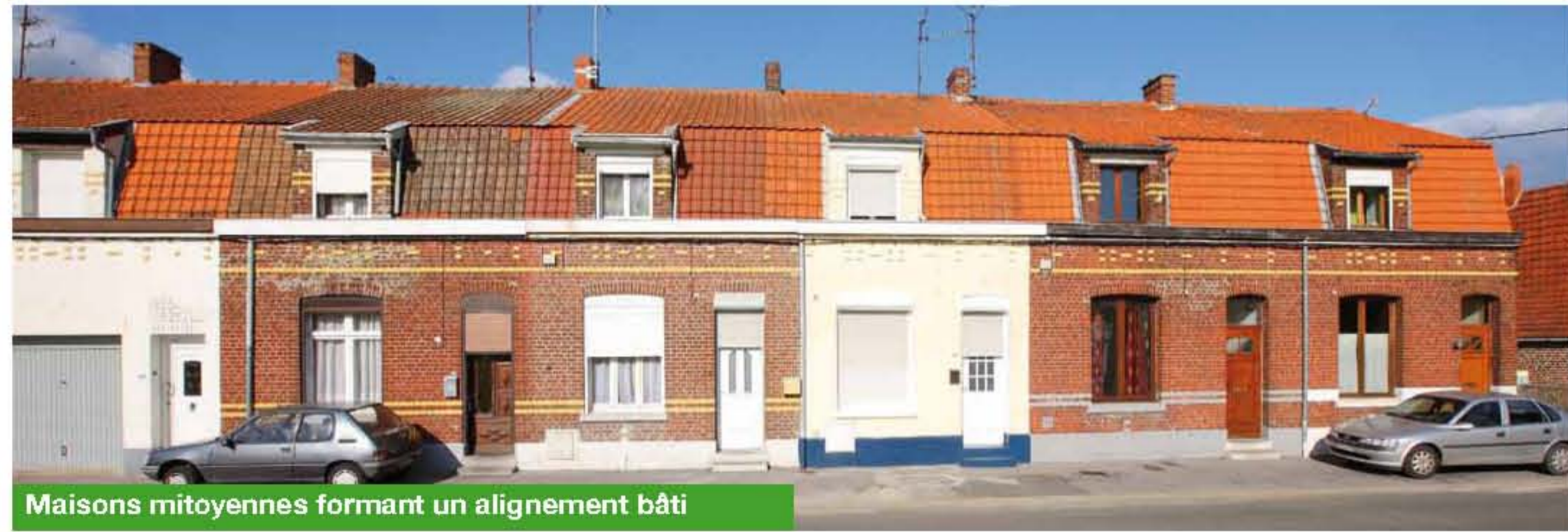
Maisons mitoyennes formant un alignement bâti
