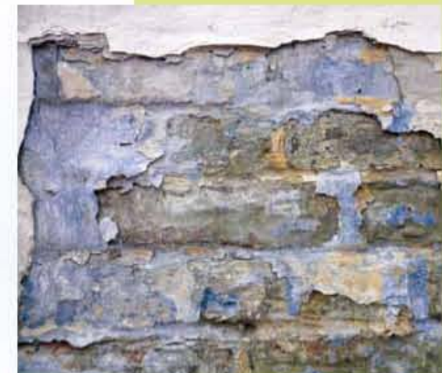
Quand les couches de badigeon successives apparaissent...
